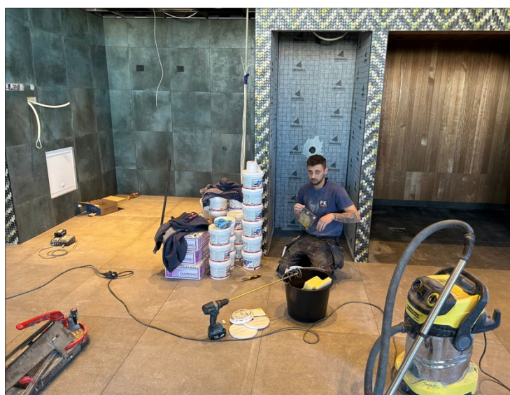
SNART FERDIG: Håndverkerne jobber med finishen nå. I slutten av mai skal bassengene fylles med vann og testen. Hele anlegget åpnes 1. juli.
