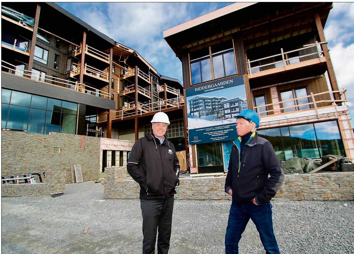
REISER SEG: Terje Fahre (t.h.) sammen med adm.dir. i Beitostølen Resort, Atle Hovi (t.v.), foran Riddergaarden. Utbyggeren har nå inngått samarbeid om leveranser av treelementer til bygget med Tinde Hytter AS på Vinstra.
